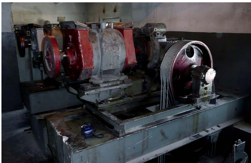
Maszynownia dźwigu z lat 70. ubiegłego wieku
